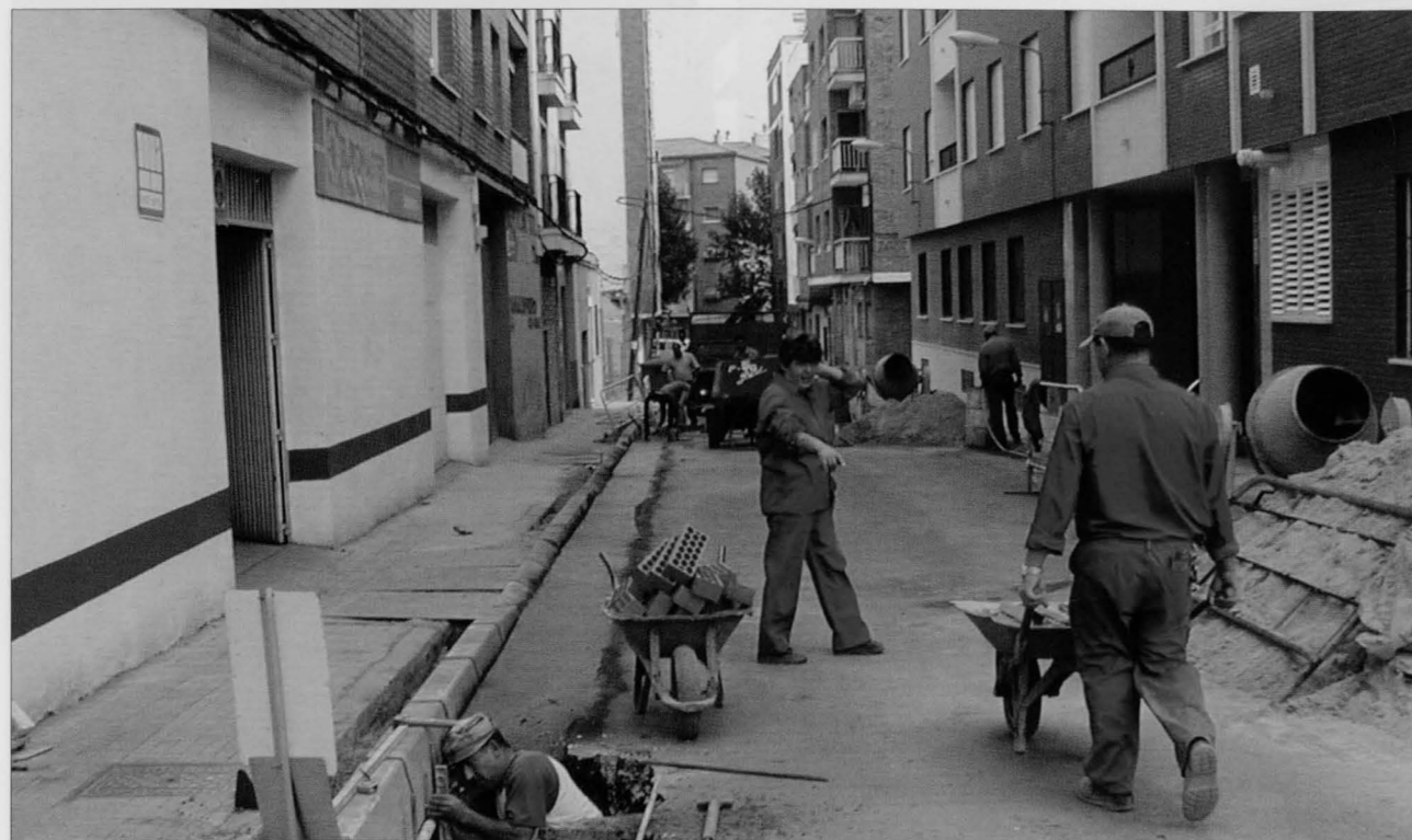
Se ha invertido 30.000 euros en la renovación de baldosas
