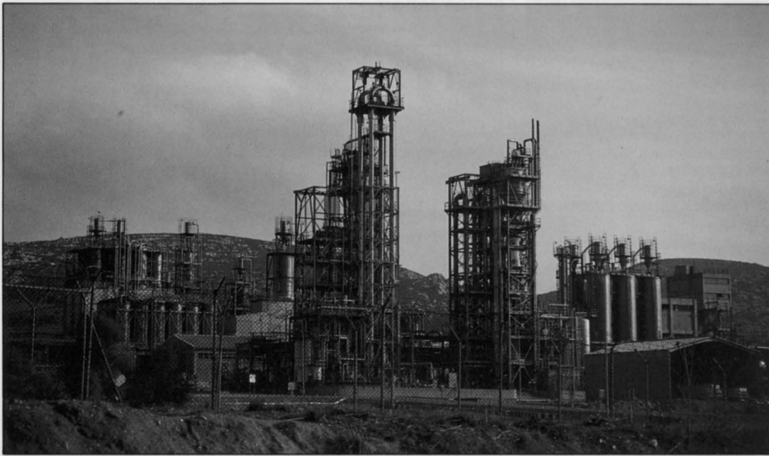
Vista parcial del Complejo Petroquímico
