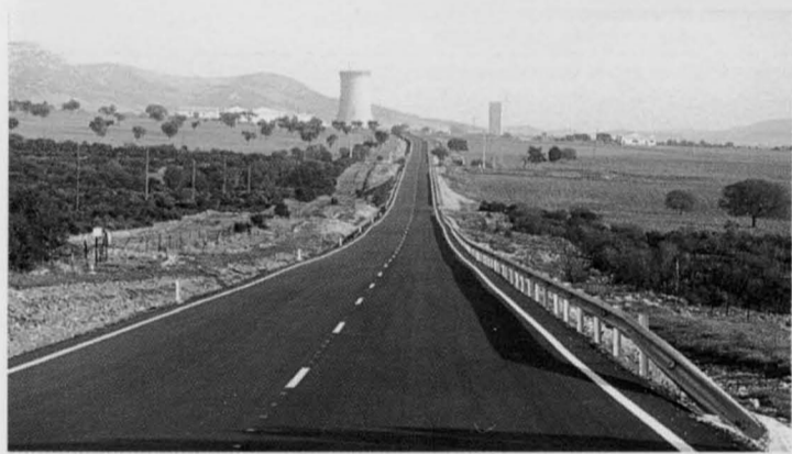
Se ha procedido al ensanchamiento de la calzada y refuerzo del firme.
