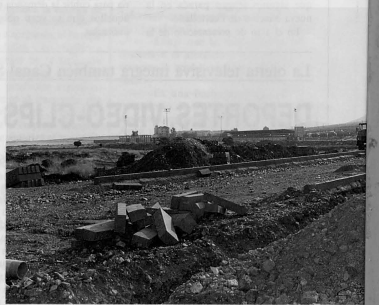
Obras de la tercera y última fase del Recinto Ferial de 60.000 m 2 , ubicado en la zona norte del casco urbano.
