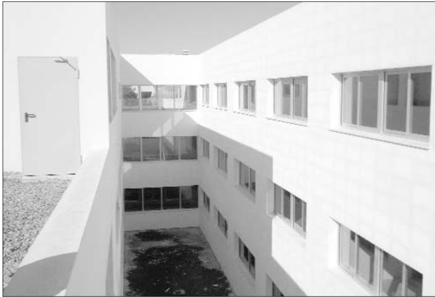
Las obras, de 6,5 millones de euros, se ejecutan en sucesivas fases
