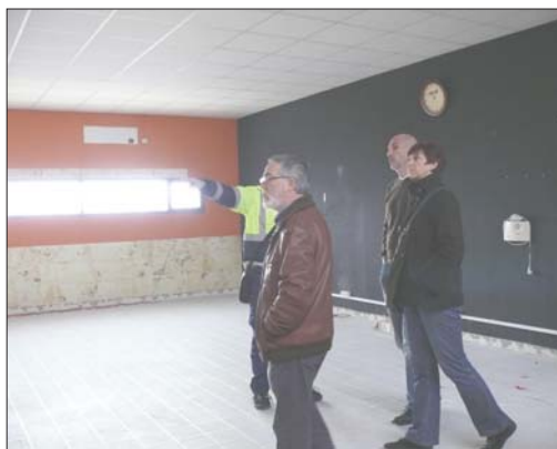
El Alcalde, el Concejal de Deportes y la Gerente del Patronato visitaron las obras
