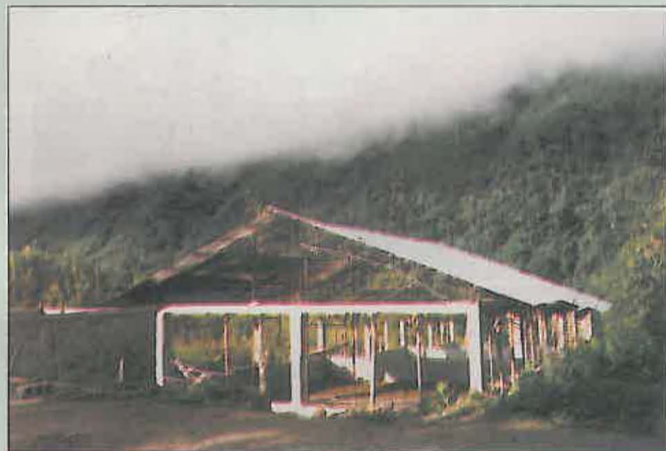
En esta segunda imagen se ve la construcción de la cubierta
