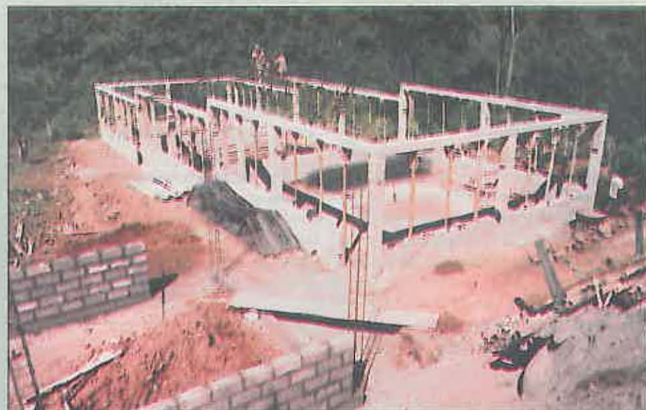
Operarios trabajan en la estructura básica de la granja. (primera fase)
