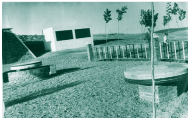
Explanada del depósito de agua en «San Isidro»
