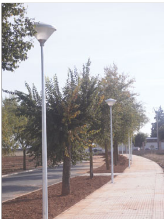
Acerado e iluminación del camino del cementerio
