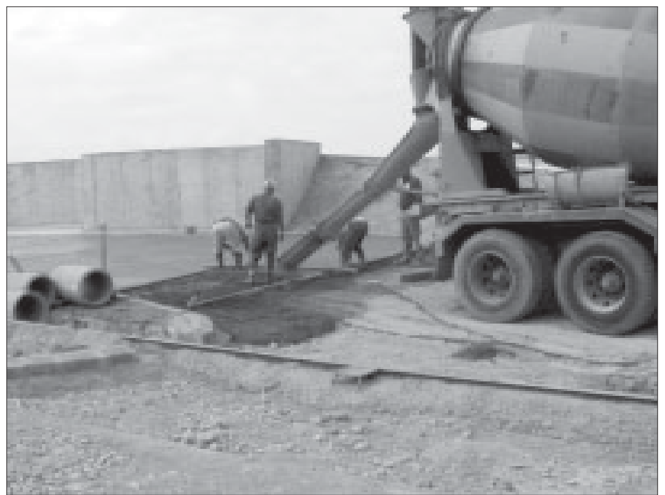
Obras para acondicionamiento del terreno en el Punto Limpio
