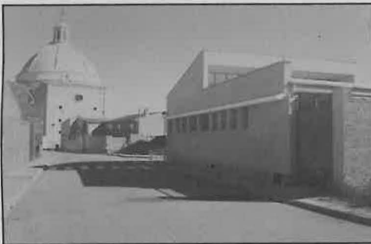
El último edificio municipal completamente acabado ha sido el Centro de Atención a la Infancia. En estos mismos días abre sus servicios, entre los que incluye el de comedor.
