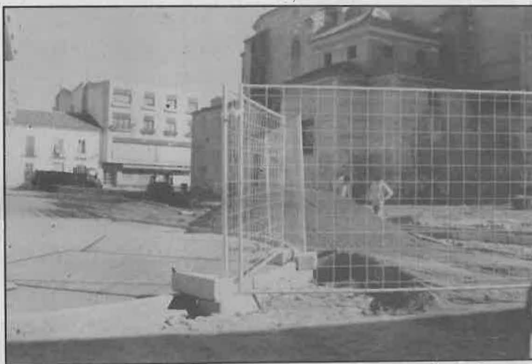
La pavimentación de calles observará la eliminación de barreras
