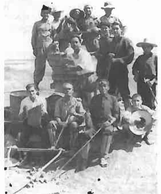
En la Dehesilla de Lara se encontraba esta cuadrilla de «marreadores» (picadores de piedra). Es una imagen del año 1950 que nos dejó Alejandro Martín Muñoz. Obsérvese las protecciones de madera para las piernas que debían utilizar estos esforzados obreros.
