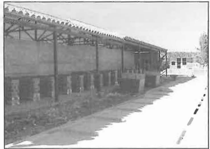
Construcción de nuevos nichos
