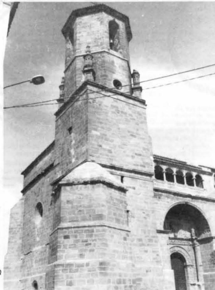
Torre y portada lateral izquierda, cuyos muros se han limpiado y consolidado y en donde se han sustituido varios sillares muy deteriorados.
