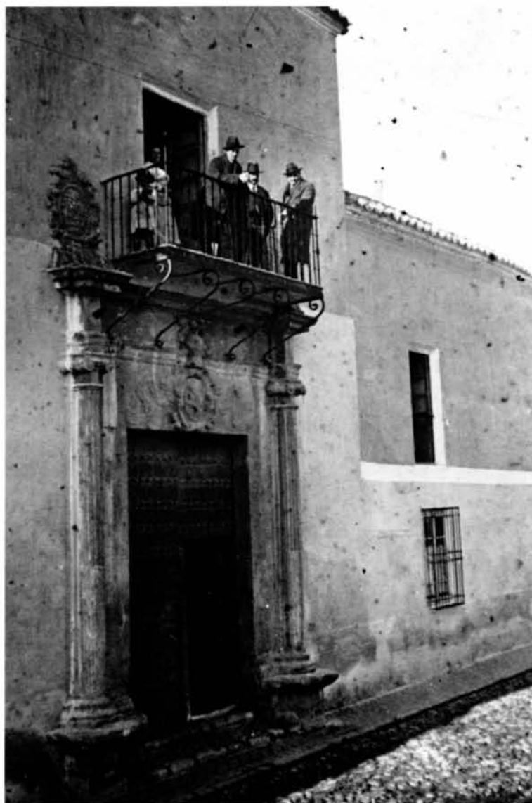
La Portada de la Casa de Hernán Pérez del Pulgar uno de los escasos restos de arquitectura del S. XV que se conservan en la ciudad.
