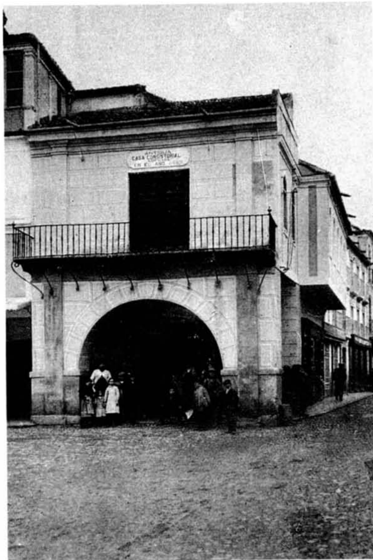
El edificio que en su día fuese Casa Consistorial sigue estando presente en la Plaza.
