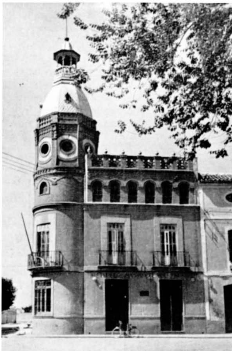
Plaza del Pilar. Sobre este edificio se levanta el actual Instituto Nacional de la Seguridad Social.
