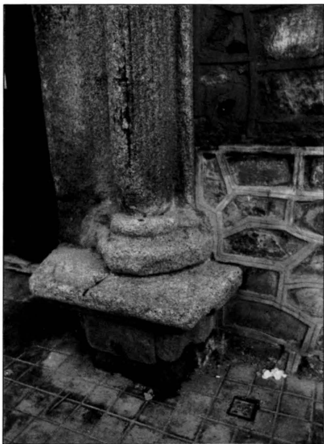
Estado de alteración de las basas de las columnas. Obsérvese la alveolización, la arenización y las patinas provocadas por microorganismos.
