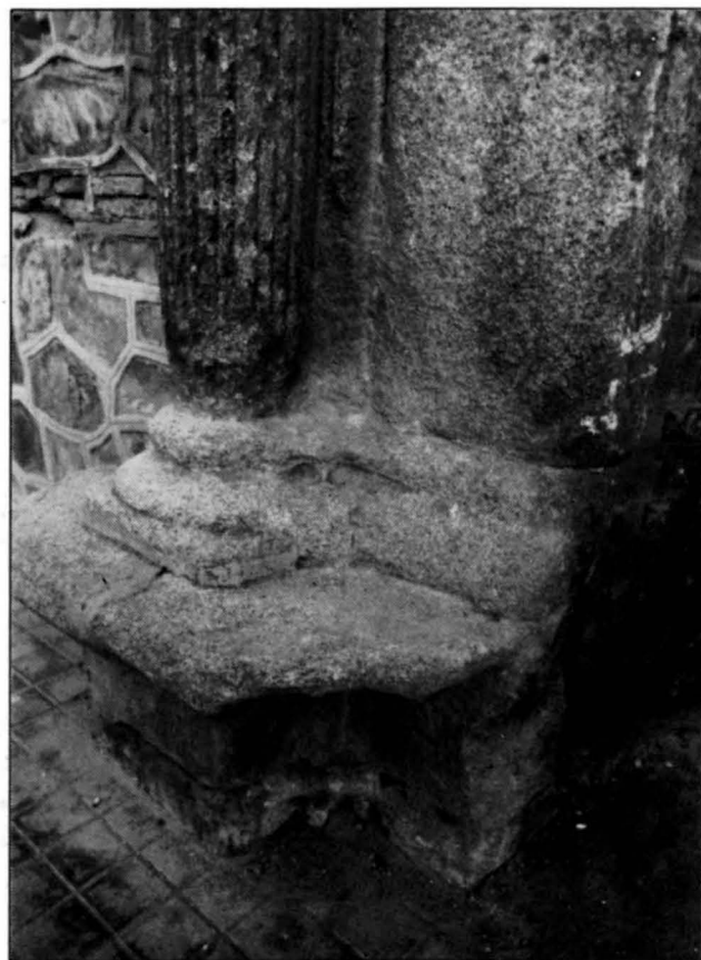
Estado de alteración de las basas de las columnas. Obsérvese la alveolización, la arenización y las patinas provocadas por microorganismos.
