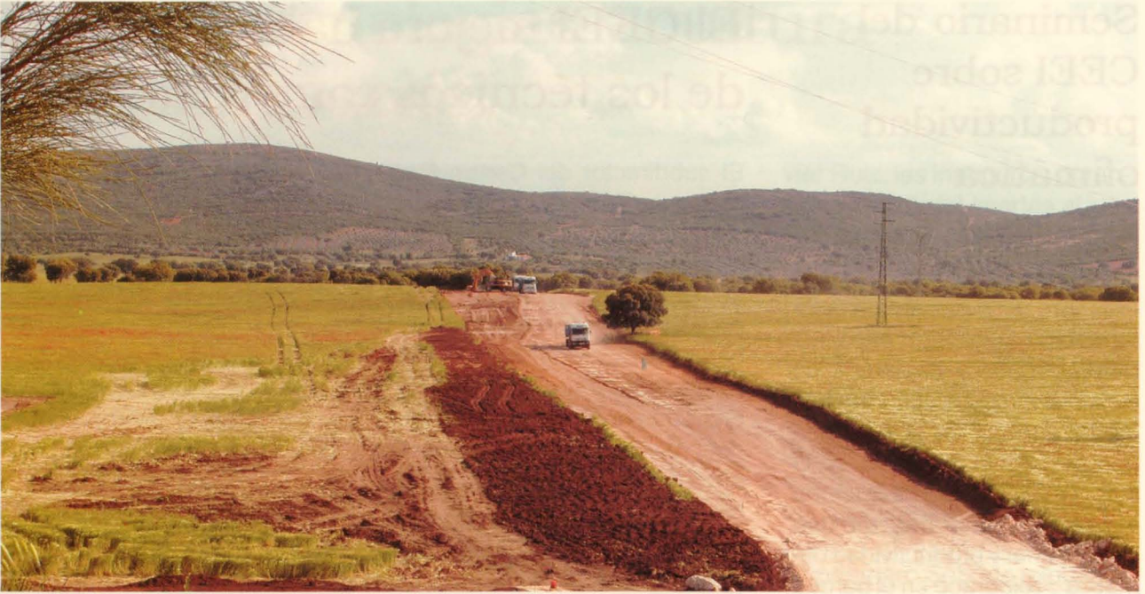
Construcción de la nueva carretera entre Villar del Pozo y Cañada
