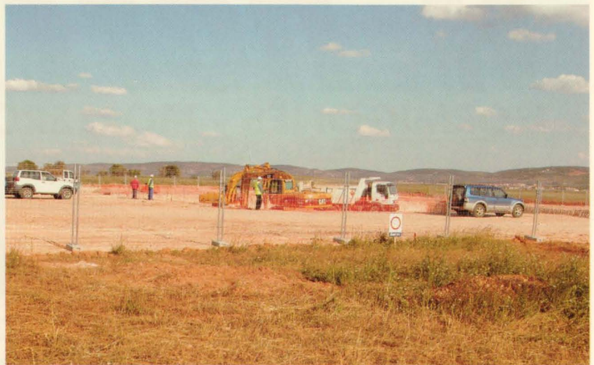
Aquí se construye la central eléctrica del Aeropuerto
