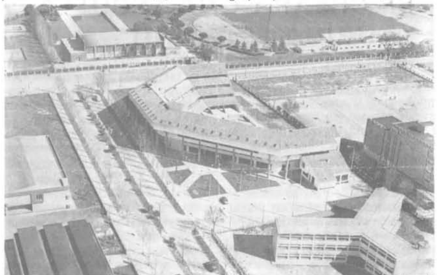
Vista parcial del Complejo Educativo y Deportivo de Ciudad Real. En el centro, el edificio del Colegio Universitario construido por la Caja Rural Provincial.
