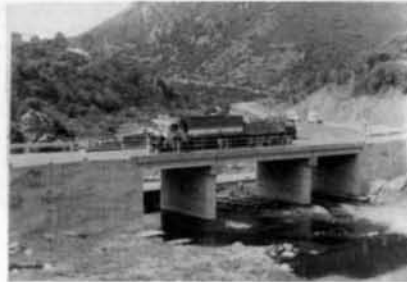
Aspecto general de las obras realizadas en una carretera provincial en las cercanías de Manzanares.
