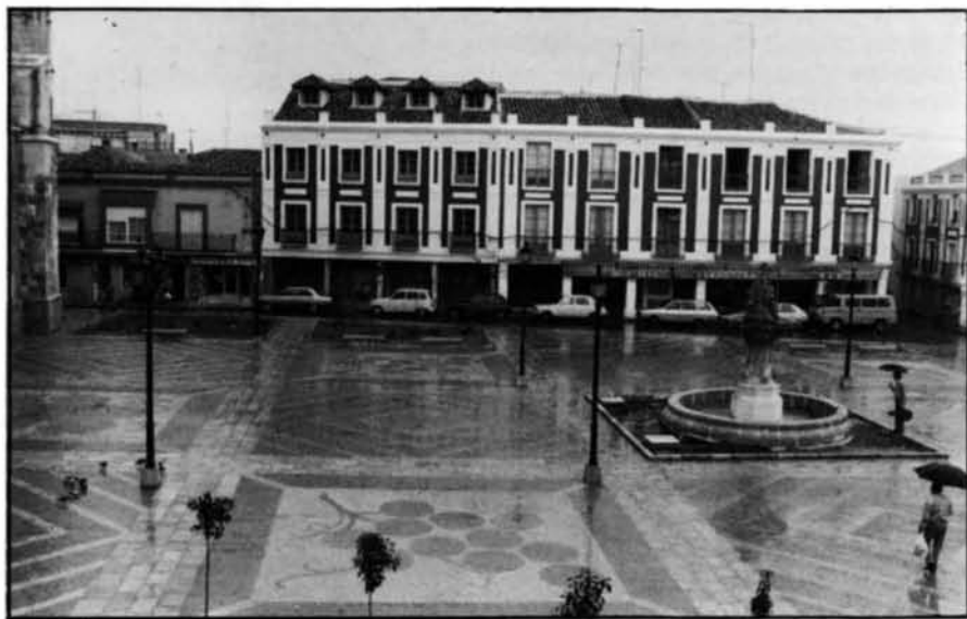
Vista parcial de la plaza, aún en obras.
