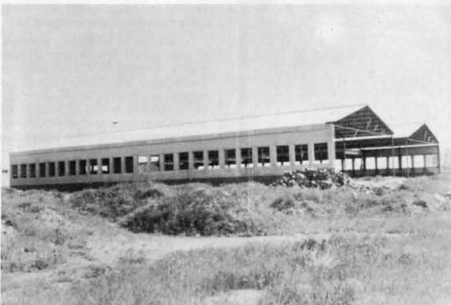
Salón de actos múltiples. Bajada a las instalaciones deportivas; en primer plano, la piscina. Naves dedicadas a los trabajos de talleres.
