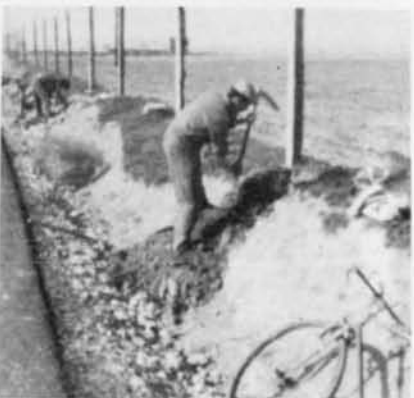
Haciendo los hoyos para los correspondientes árboles en el carreterín de las Tablas.
