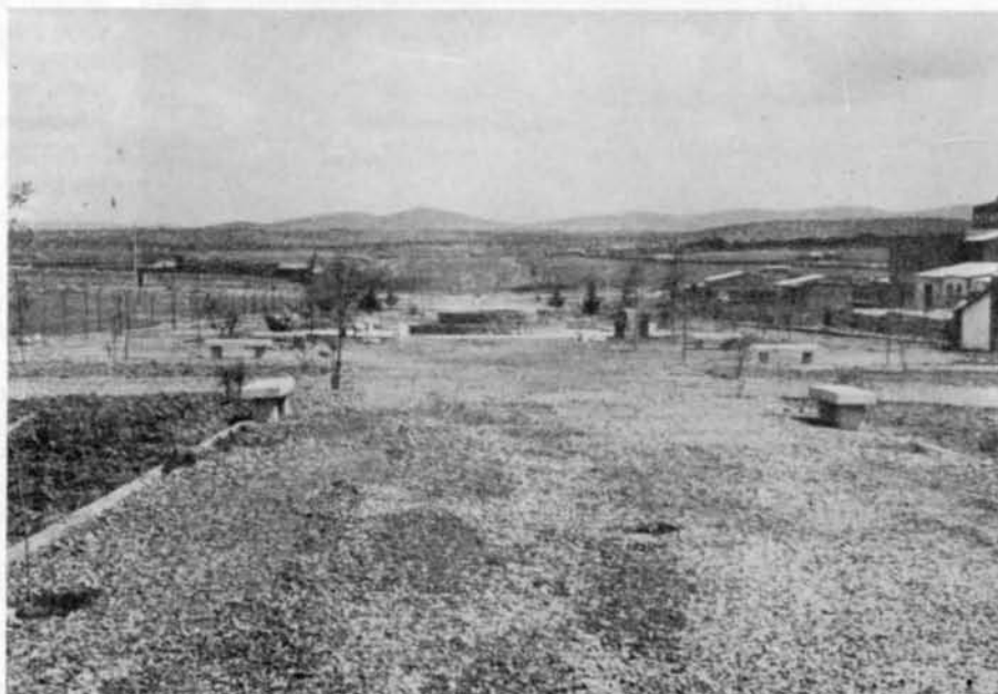
El parque de Agudo, de considerables dimensiones, se encuentra en avanzada fase de terminación.
