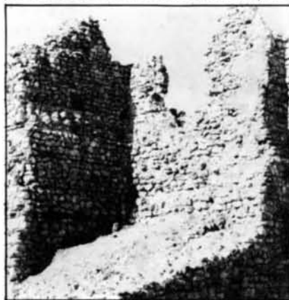
Los voluminosos contrafuertes de la muralla de la fortaleza que han salido a flote.
