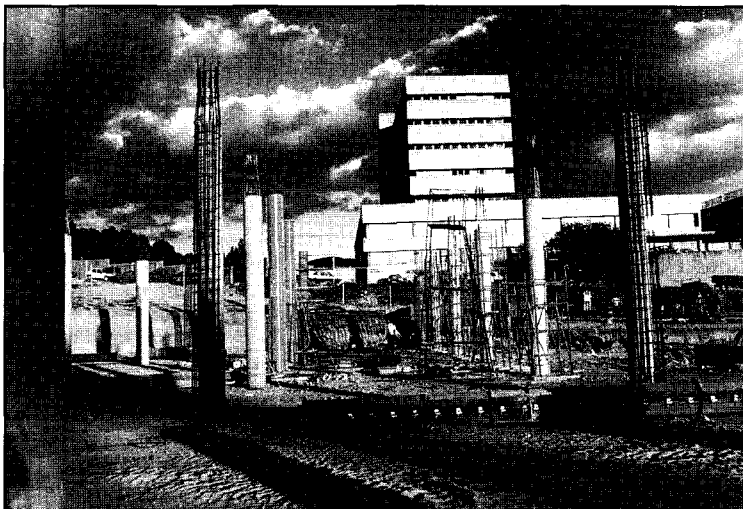
Panorámica de las obras que se están realizando en el Campus de Cuenca
