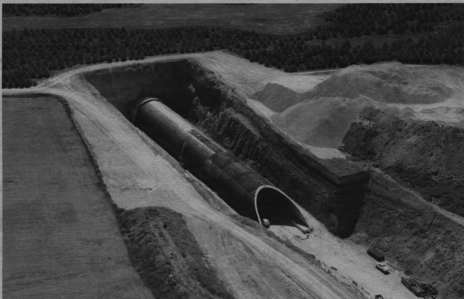
El túnel de Horcajada, de casi 4.000 metros, es el segundo más largo de la línea de alta velocidad Madrid-Levante. Está situado entre las localidades conqueses de Horcajada de la Torre y de Naharros.
