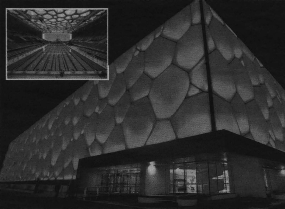
Un foso rodea el Centro Nacional Acuático, por lo que se requiere de varios puentes para acceder.
