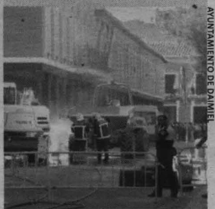
El Servicio de Emergencias desalojó los inmuebles de la calle Mártires de Daimiel por la amenaza de un escape de gas, tras la rotura accidental de una tubería.
