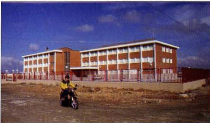
El nuevo Instituto de Enseñanza Secundaria aún no ha abierto sus puertas
