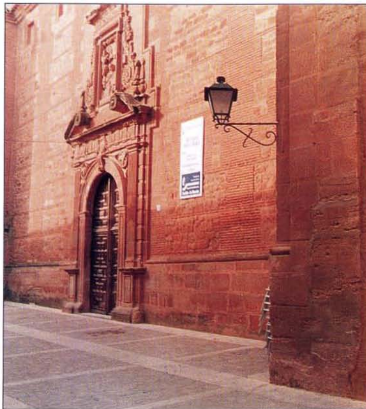
Nuevo acceso al Convento de la Encarnación tras las obras rea
