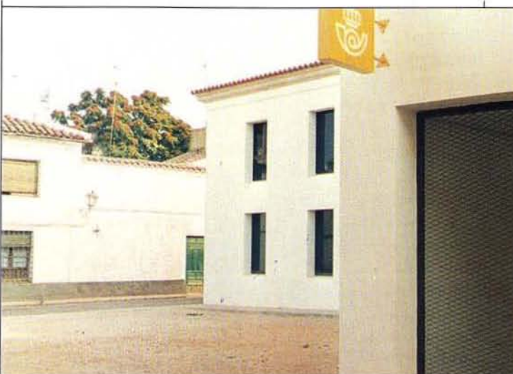
Nuevo edificio de Correos, obra de la Dirección General de Tel
