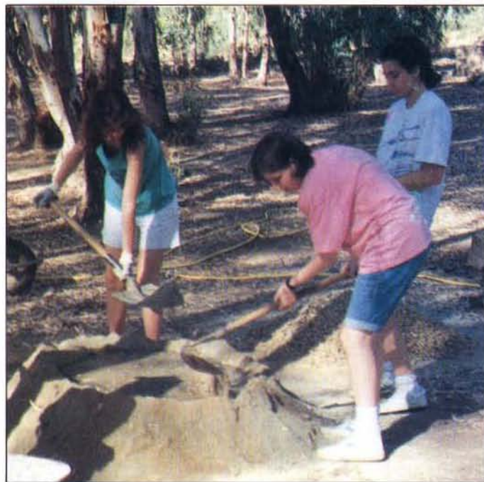
En Almadén se rehabilitaron merenderos y otros lugares de ocio.
