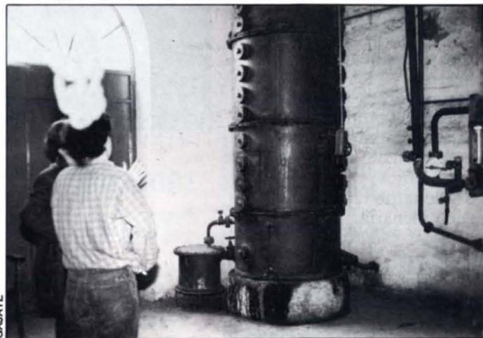
Una de las torres de destilación de vinazas.
