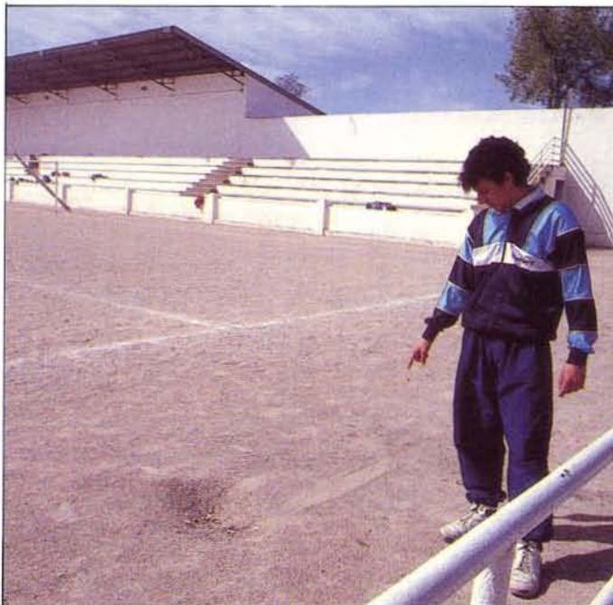
Tras el accidente en el que perdió el riñón Julio César, se cubrió la zanja y se distanció la valla del terreno de juego.
