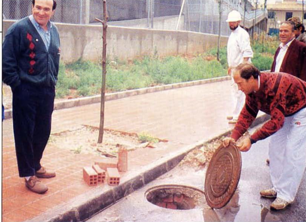
Los técnicos inspeccionan los alcantarillados y las tuberías de la urbanización Nuevo Parque.
