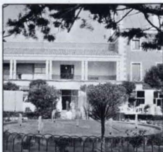
La fuente de la plaza ha sido reinstalada.
