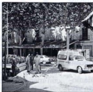
La grúa se retira tras colocar de nuevo la farola.
