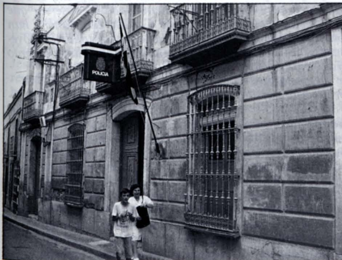
Los agentes piensan que el actual edificio de la Comisaría no reúne las condiciones adecuadas.
