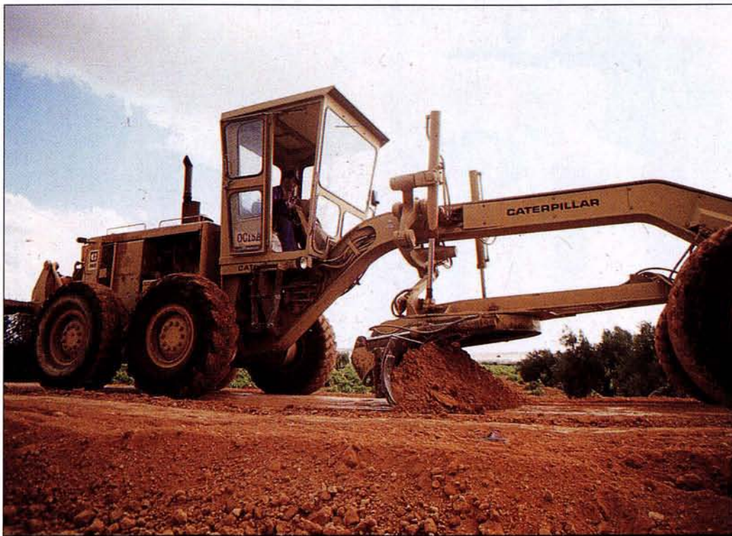
La Mancomunidad del Campo de Calatrava cuenta, entre otras muchas cosas, con un patrimonio en maquinaria de obras públicas superior a los cuarenta y cinco millones de pesetas
