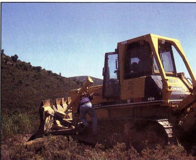
Un fuerte contingente de medios técnicos y maquinaria fue movilizado.
