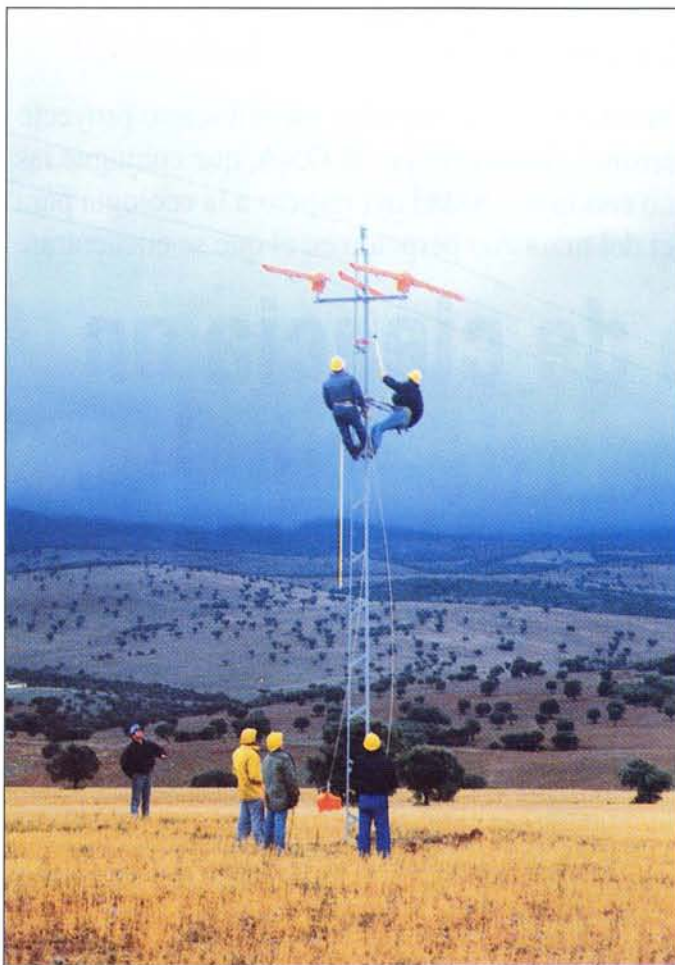
Colocación de las crucetas de protección de las aves rapaces
