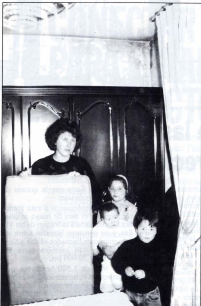
María Isabel Mora muestra los efectos de la humedad sobre una alfombra del domicilio, mientras en las paredes se ven las manchas negras.
