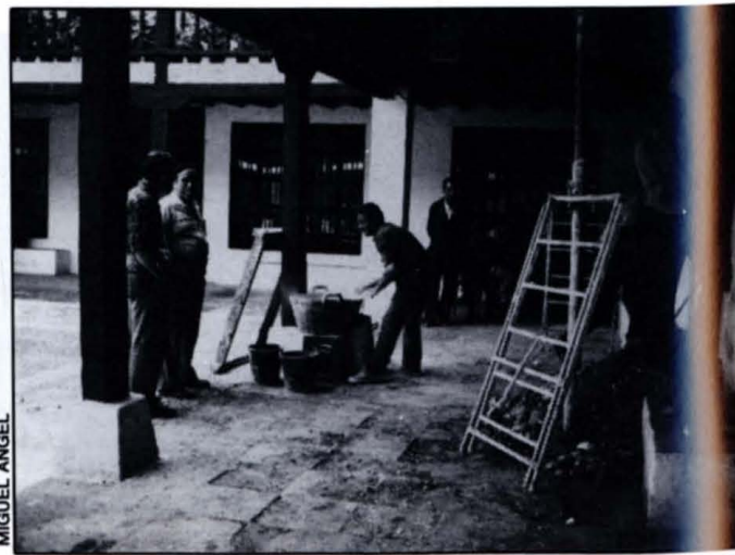
Arreglando el bar. En la bella Plaza de España de Puerto Lápice un grupo de hombres trabaja reformando un local. Los atareados trabajadores tendrán luego su justa recompensa cuando el bar esté arreglado.
