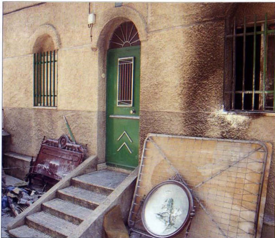
La vivienda de Felicidad Díaz ha quedado destrozada. Protección Civil acudirá en los próximos días para examinarla y eliminar rastros de gasolina.
