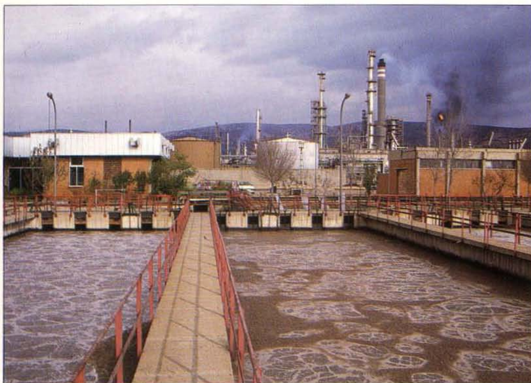
En la planta de tratamientos de residuos se produjo el fatal accidente que le costó la vida a un trabajador e hirió gravemente a otro.
