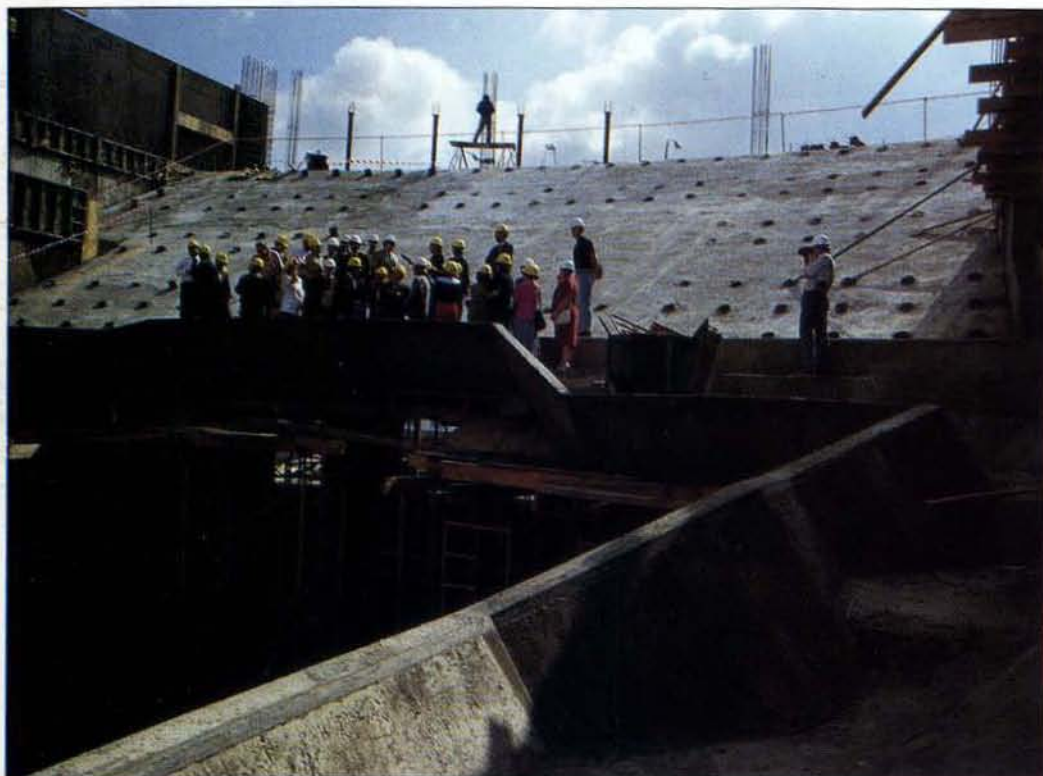
El centro cultural de Puertollano va a costar 1.367 millones de pesetas y será el más grande y el más moderno de la provincia.
