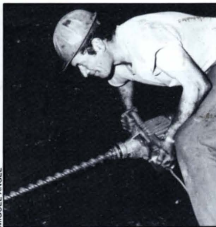
Los martillos eléctricos permiten la colocación de las cargas explosivas.
