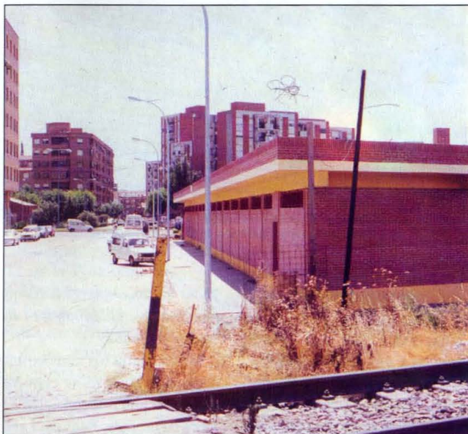
Como se puede apreciar, la puerta de entrada a la piscina está muy cerca de la vía.
