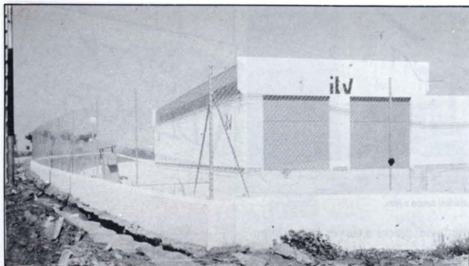
La ITV causó los cierres del suministro de agua potable.
