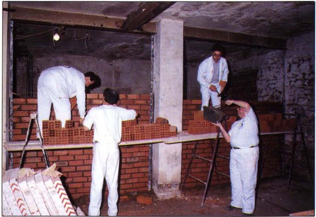
En los edificios de la antigua factoría se están realizando diversas obras.
