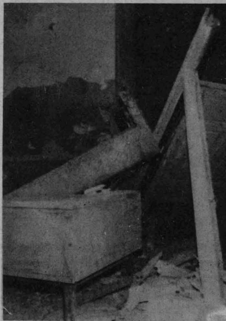
Vista parcial de las instalaciones de la c/ Caballeros, esquina Camarín
