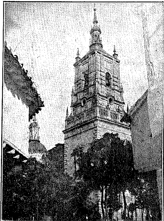
Torre de la iglesia de Orgáz (Toledo)
