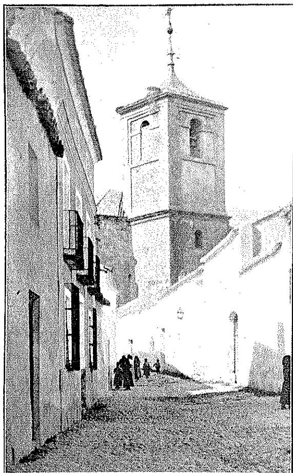
VILLARRUBIA DE LOS OJOS.—TORRE DE LA IGLESIA PARROQUIAL. Fot. Maján.
