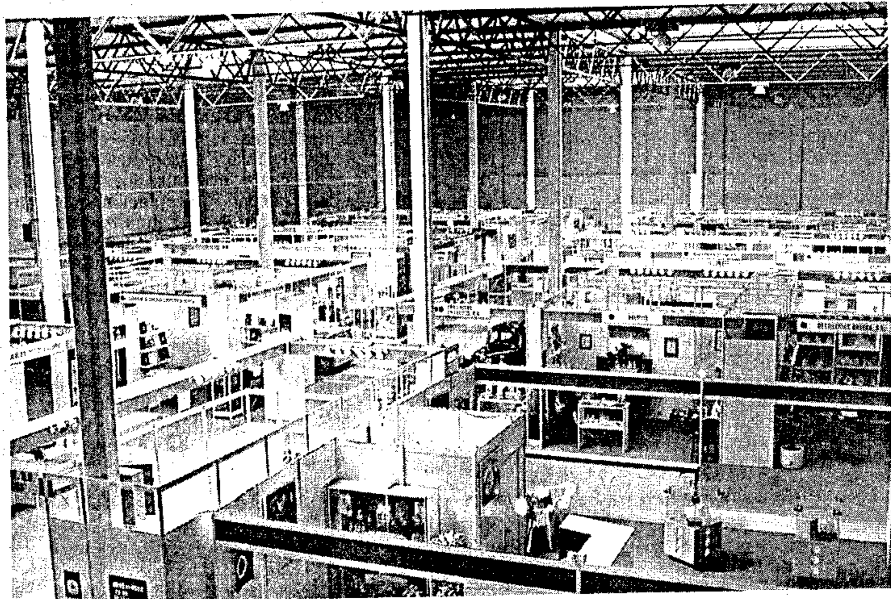
El ferial se extiende en 4.400 metros cuadrados, con nueva insonorización y sistema de refrigeración
