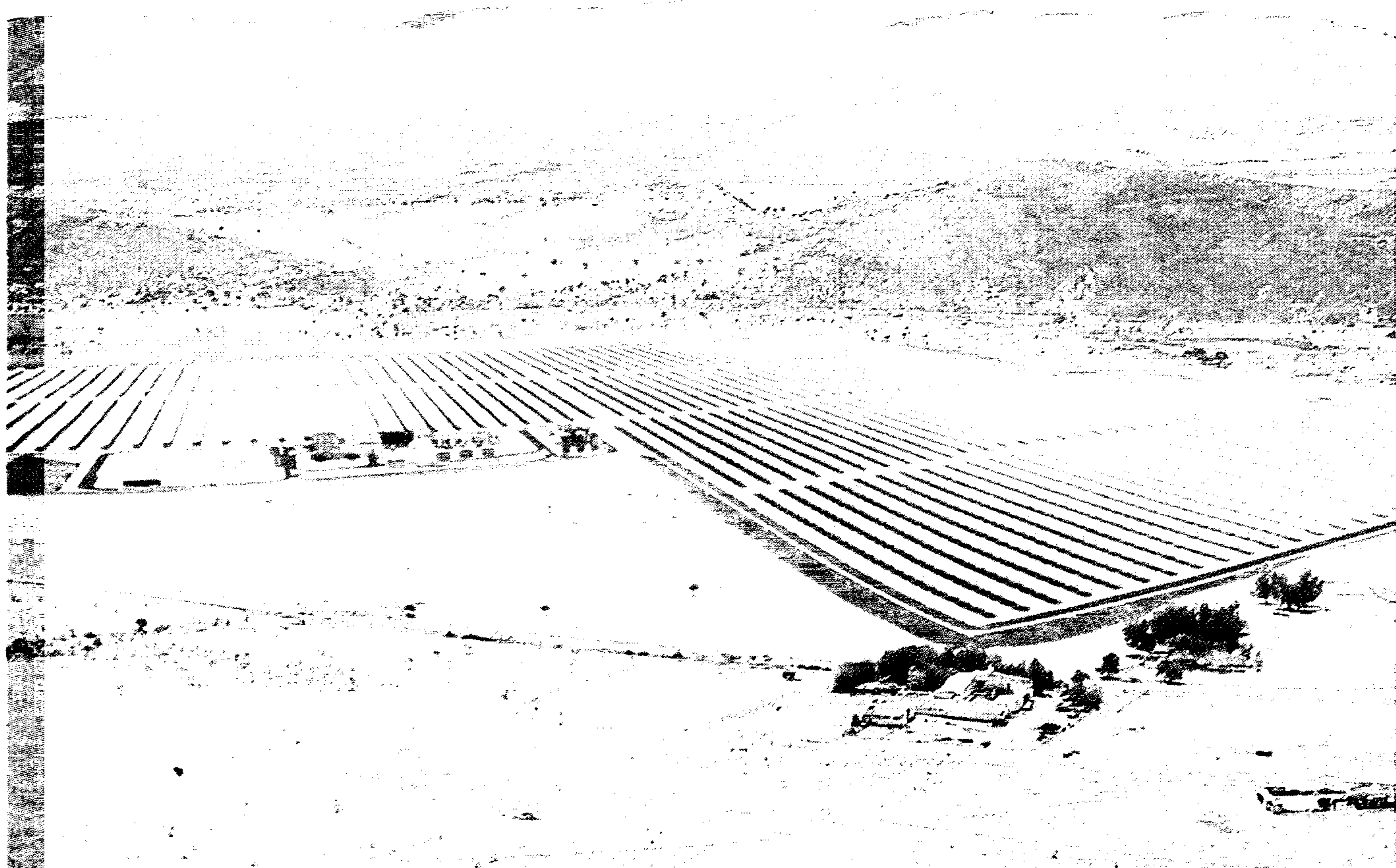
Panorámica de la central termosolar que Iberdrola está construyendo en Puertollano
