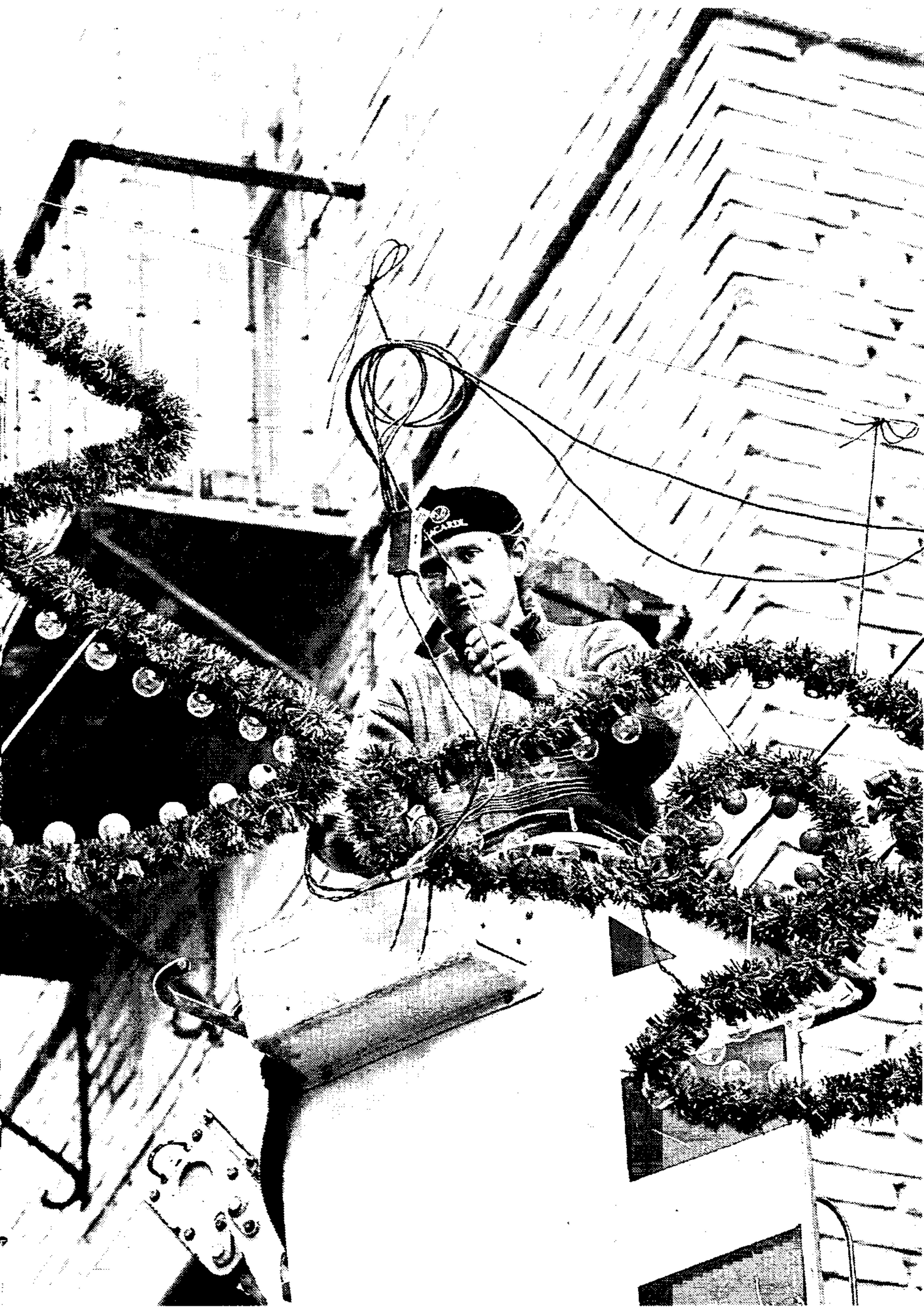
Un operario instalaba esta semana las luces de Navidad en Toledo
