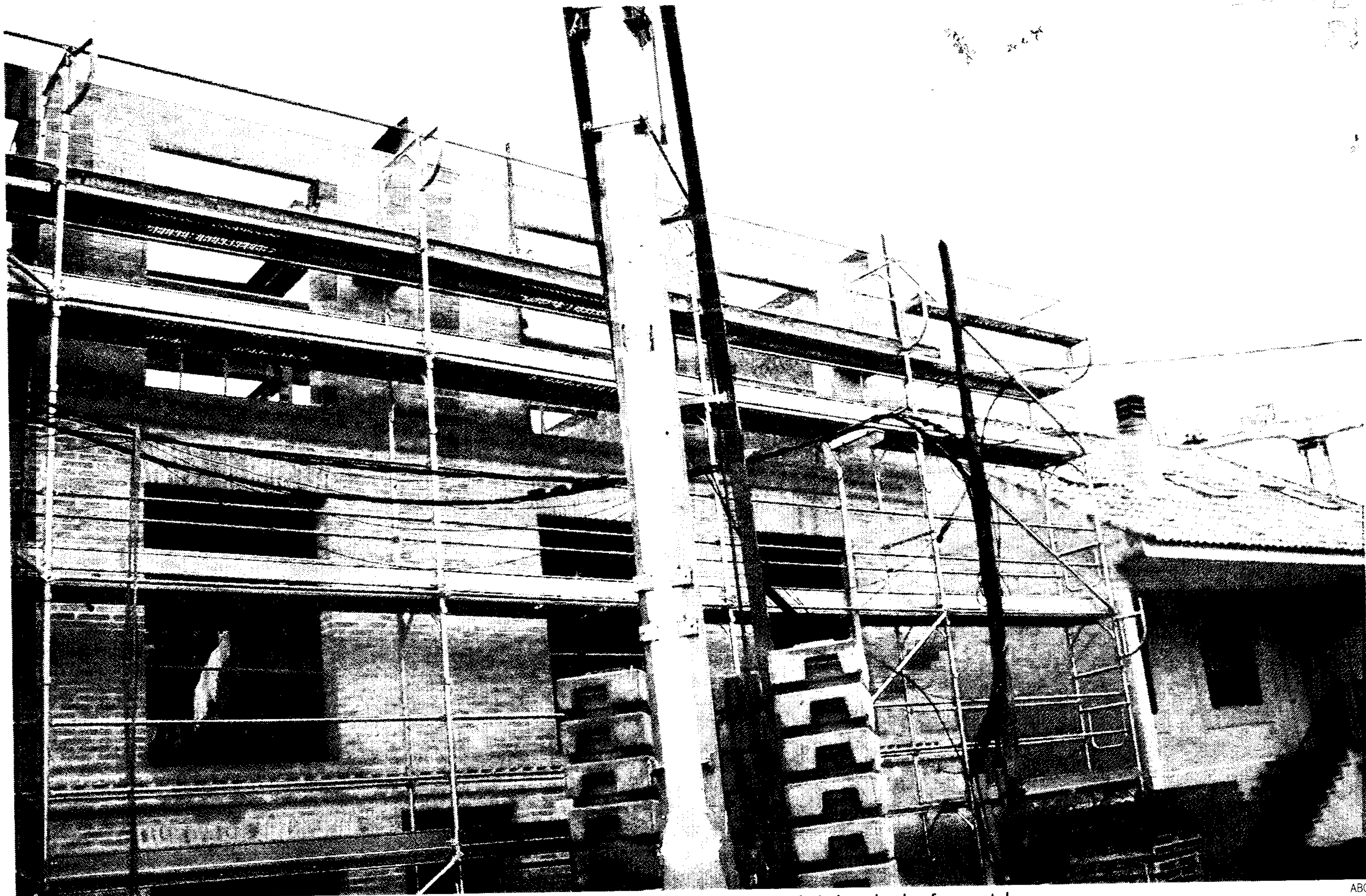
Desde el tramo más alto de los andamios de esta obra, en la localidad toledana de Bargas, cayó un trabajador; el golpe fue mortal
